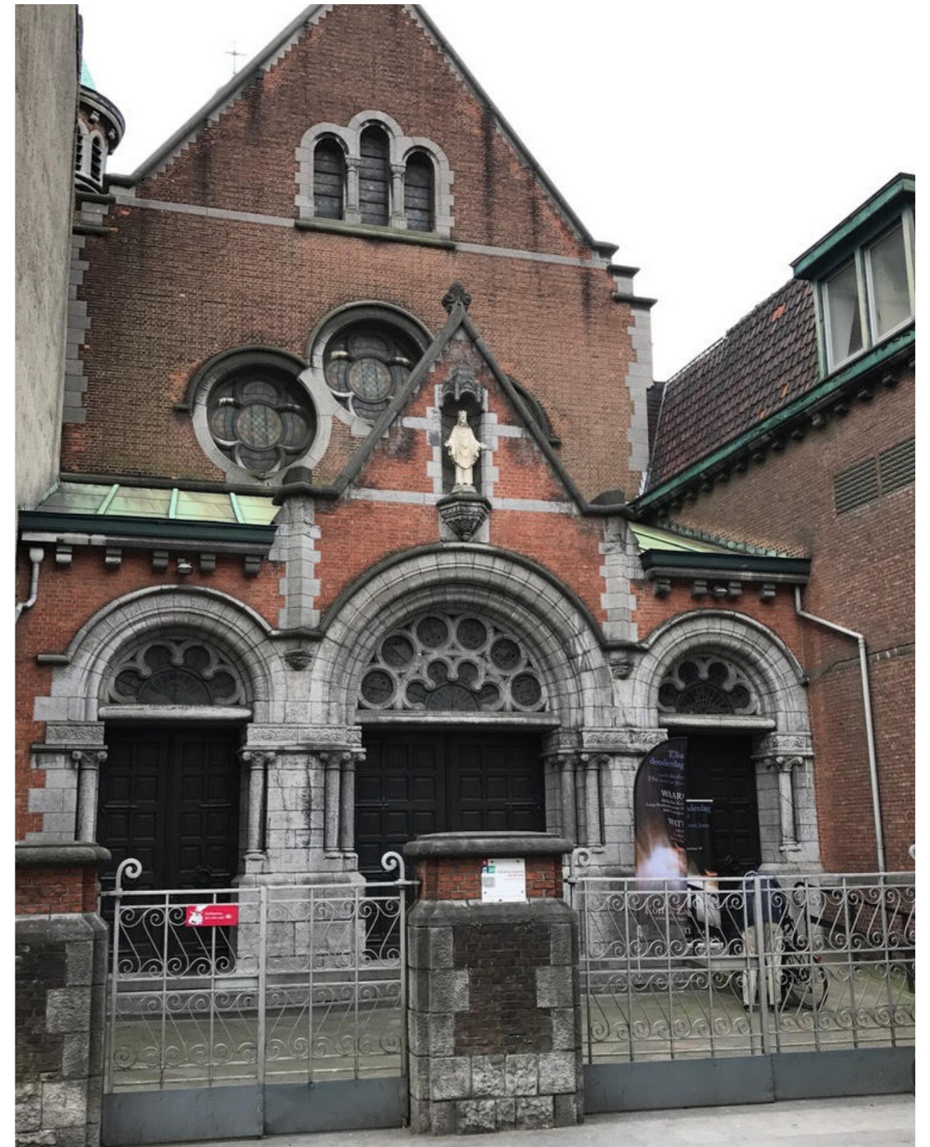
Beperkte ruimte vóór het kerkgebouw
