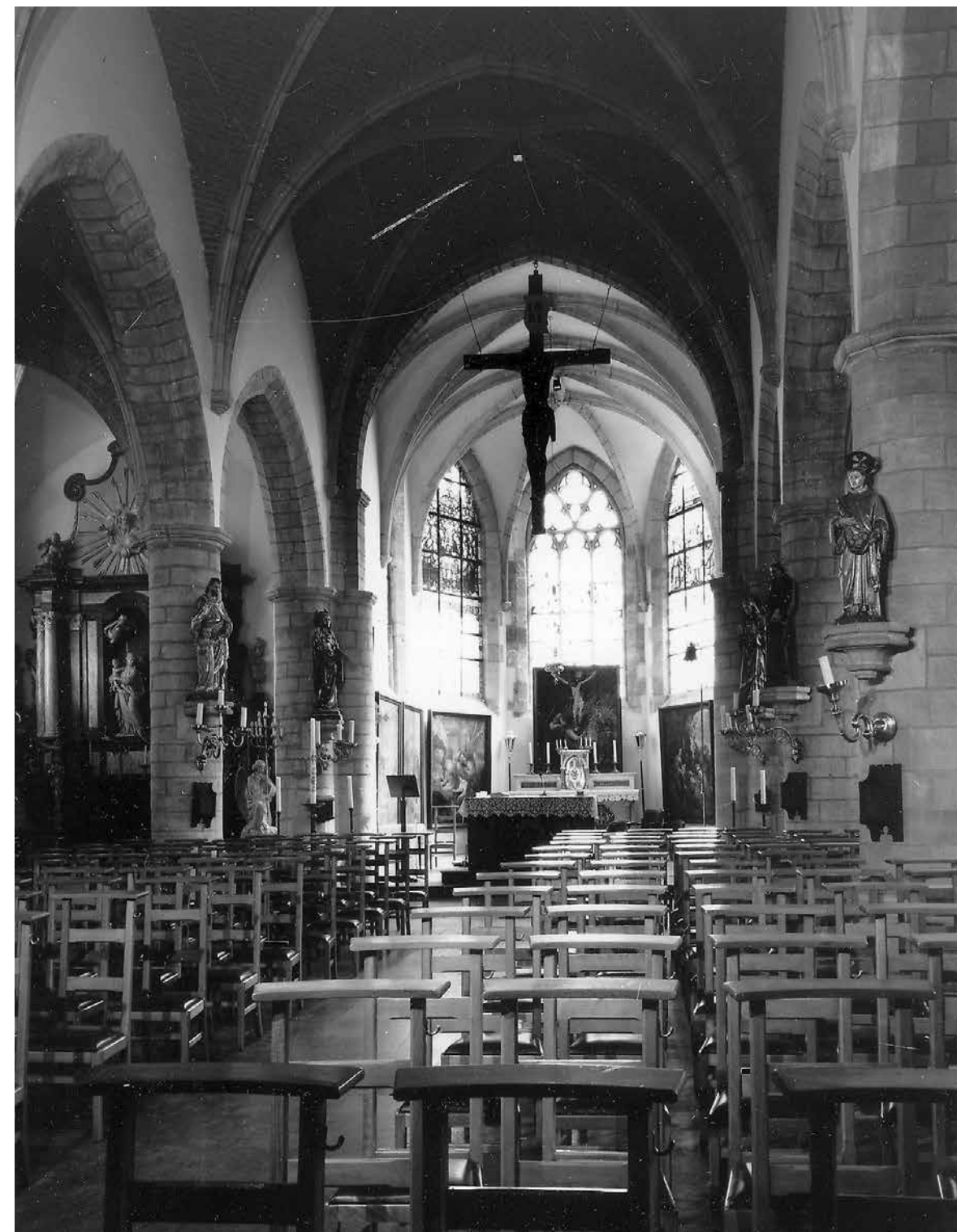
Zicht naar koor, 1979, met verlaagde koorramen, muren wit gevefnd. Bron: KIKIRPA, cliché M138406
